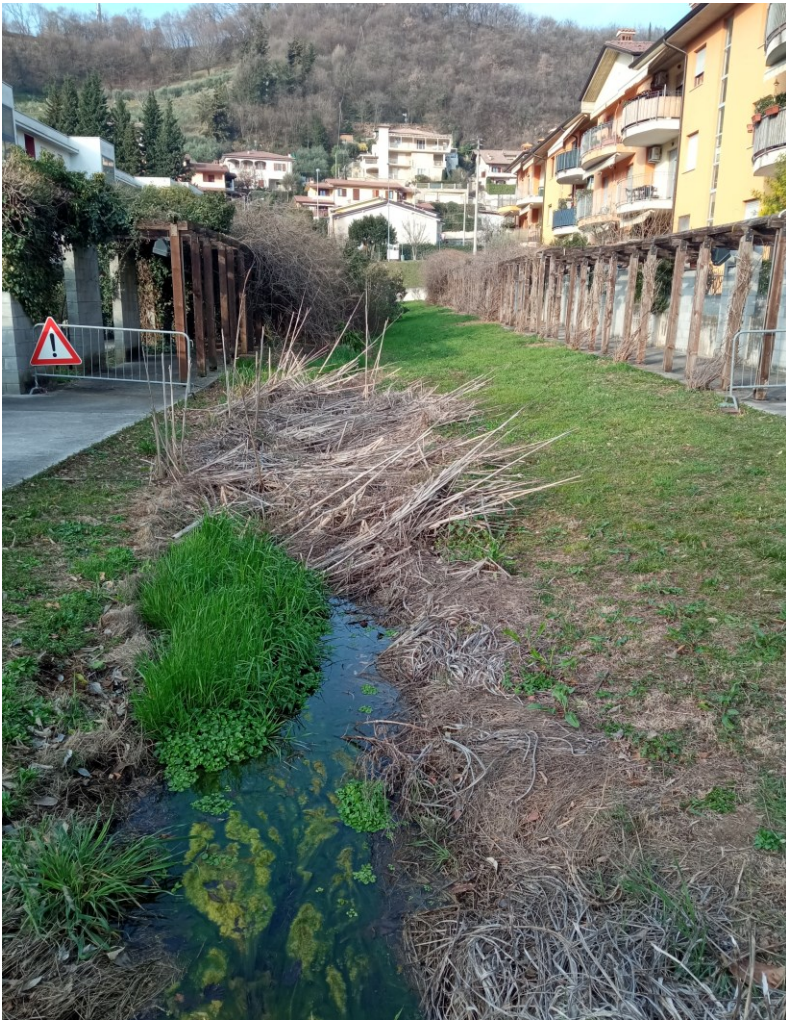
Figura 1 Prima dei lavori
