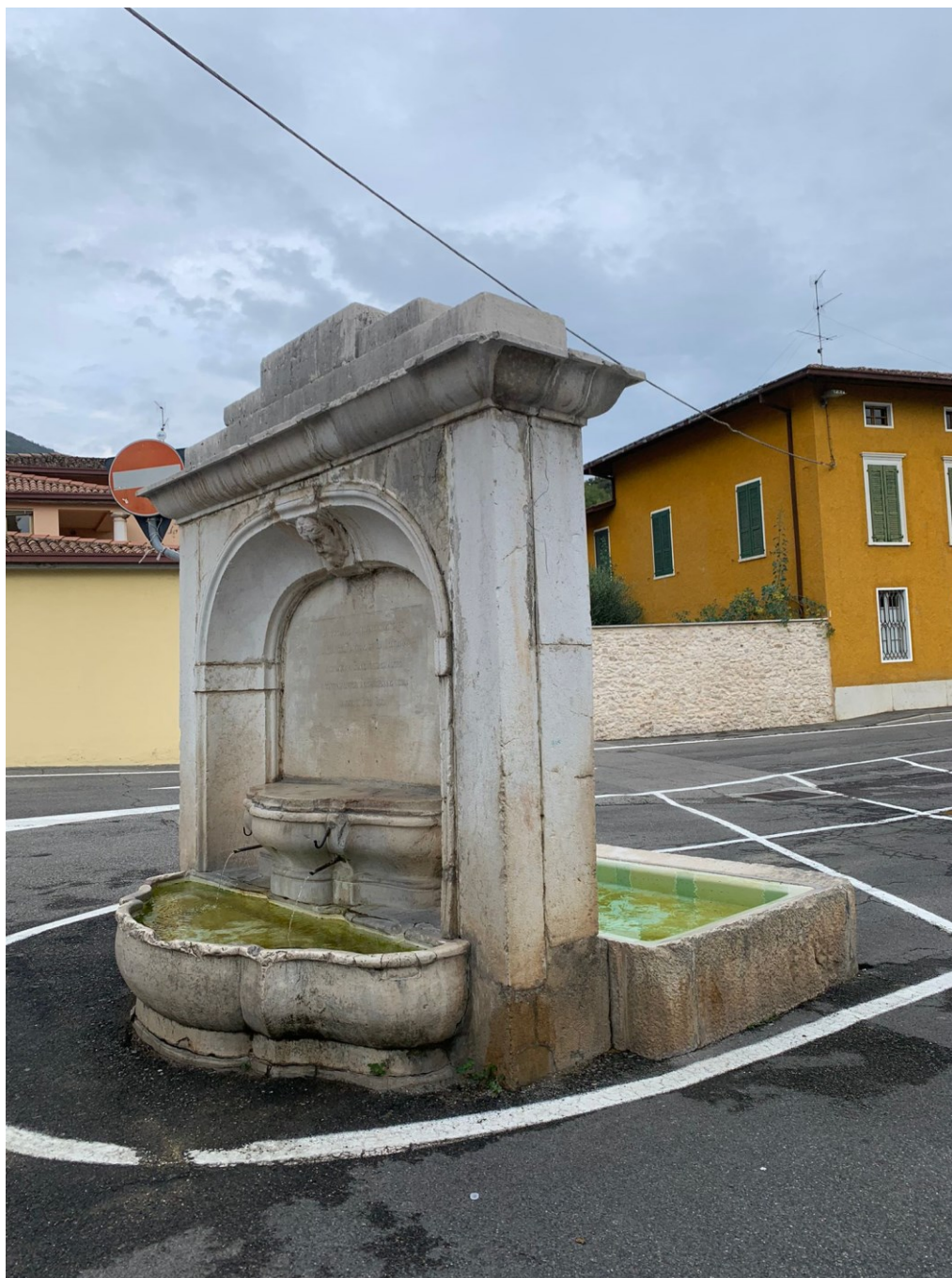
Figura 8 Fontana di Via Verdi prima del restauro
