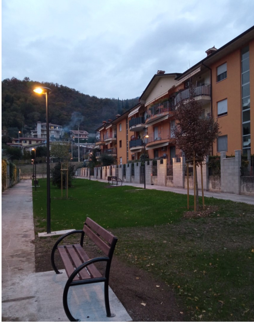
Figura 2 Dopo i lavori
