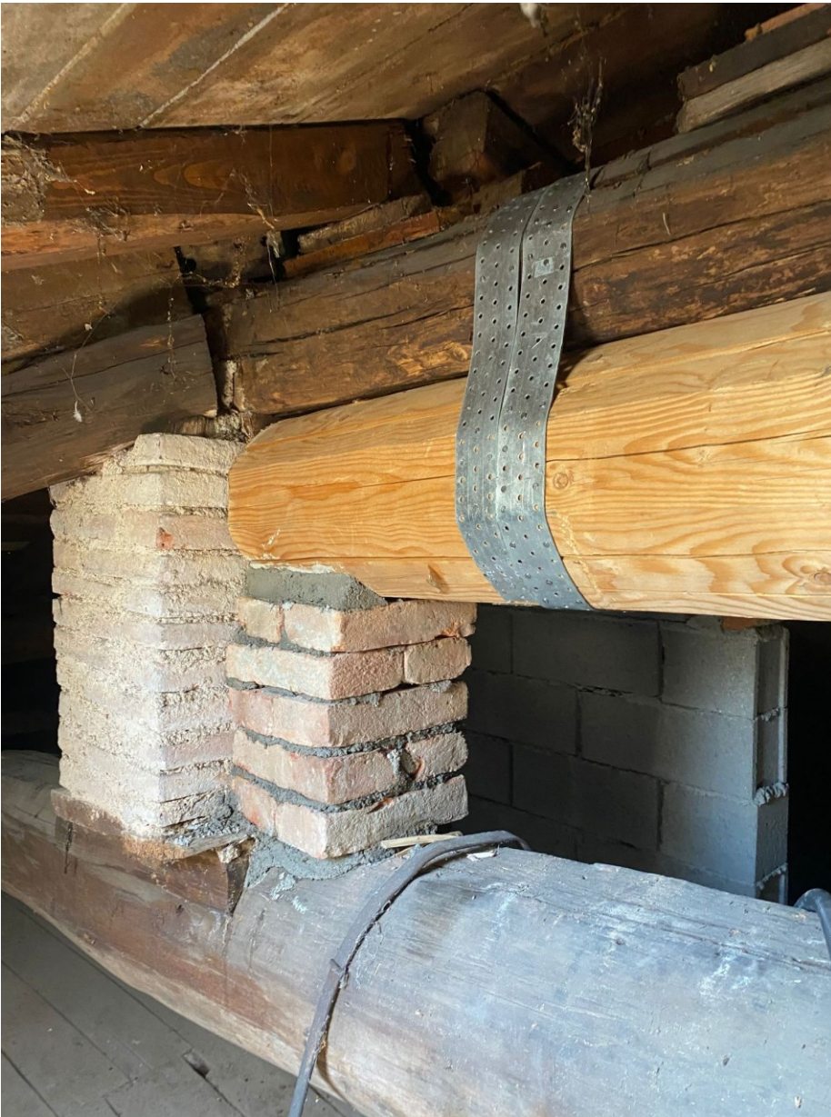
Figura 4 Trave di colmo a seguito dell'intervento
