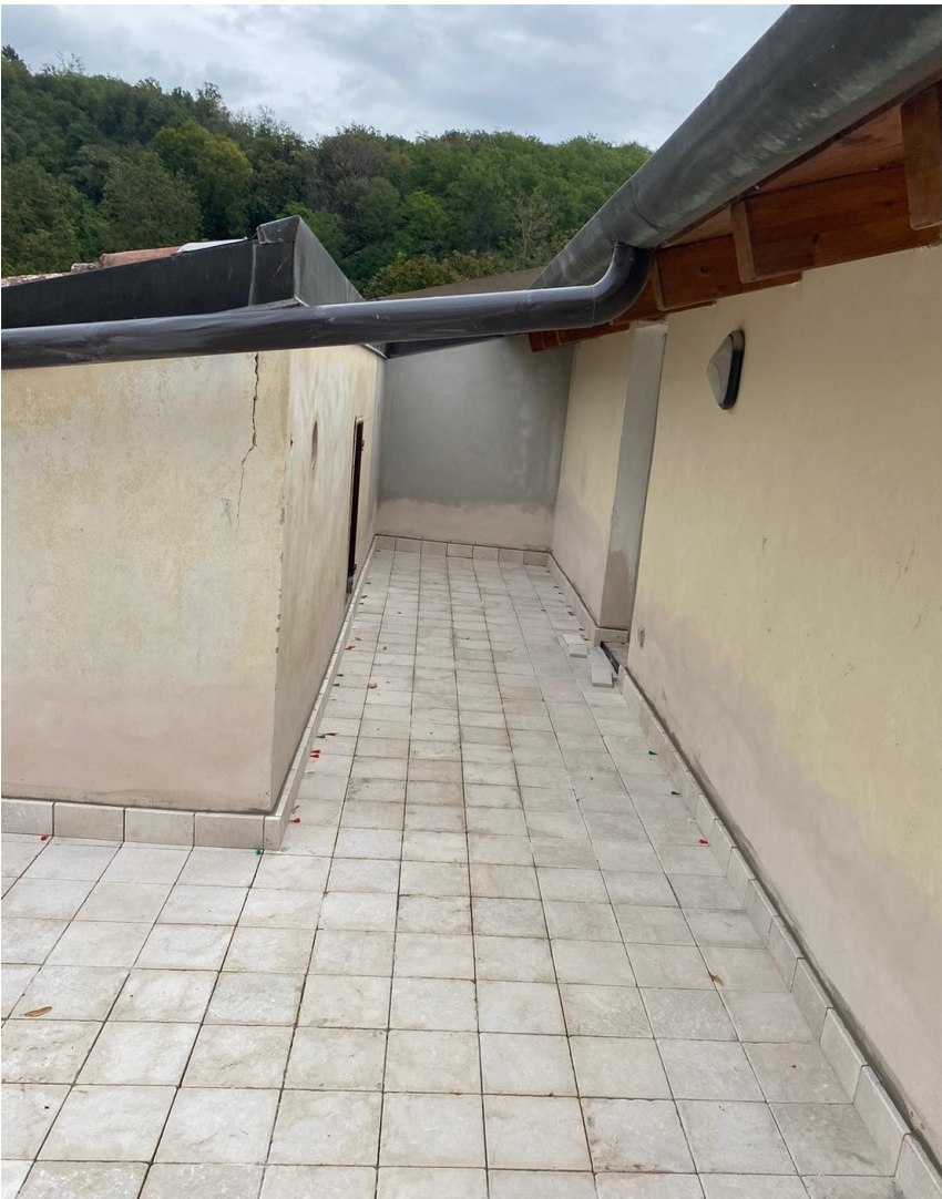
Figura 6 Pavimentazione dopo l'intervento
