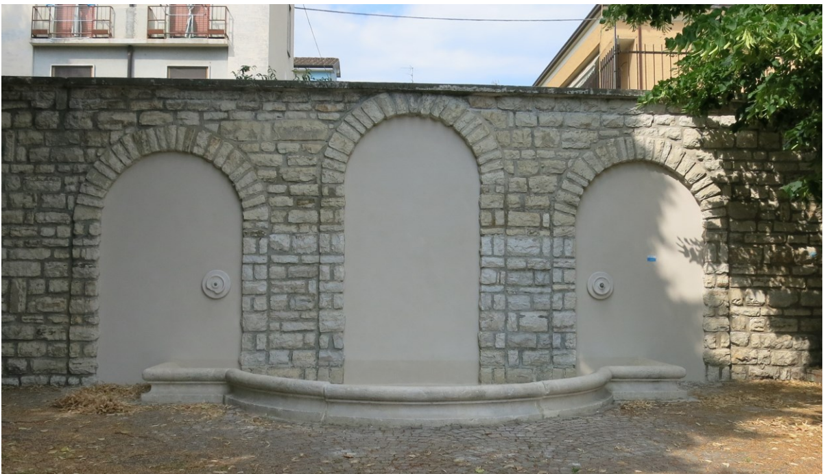
Figura 11 Fontana di Via Merano dopo l'intervento di restauro
