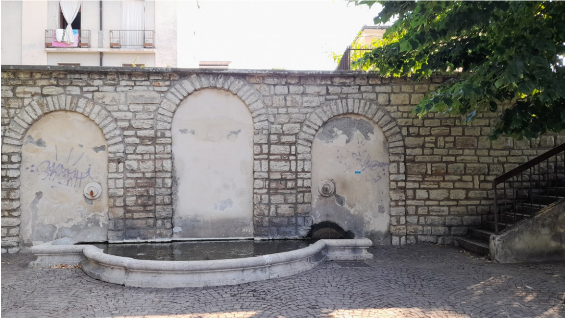
Figura 10 Fontana di Via Merano prima dell'intervento di restauro
