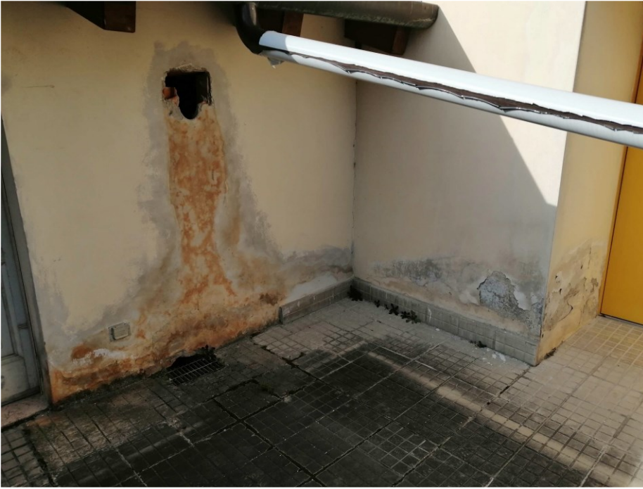
Figura 5 Pavimentazione prima dell'intervento
